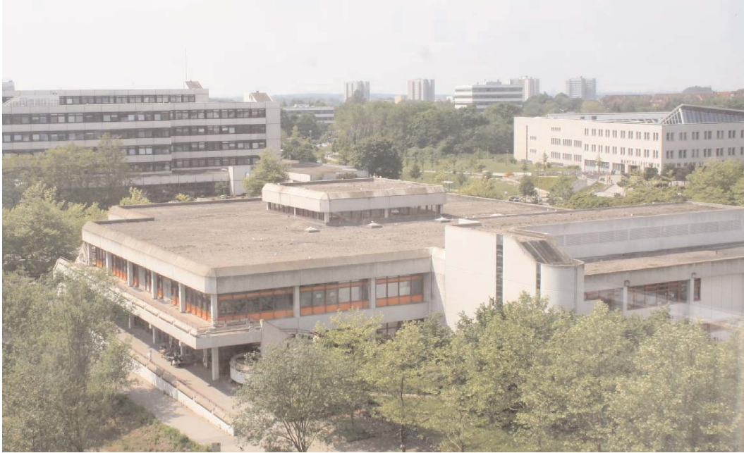
Abb. 5: Mensa 2 der Universität Kiel. Die vollständige Netzabdeckung bewirkte die Auflösung der ehemaligen Sturmmöwenkolonie auf diesem Dach; führte allerdings in den Folgejahren zur Besiedlung bzw. Zunahme der Bruten auf den Dächern benachbarter Institute und der Universitätsbibliothek.
