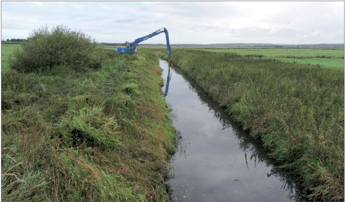
Abb. 7: Eine Au in der Fielser Niederung/HEI wird durch Baggerarbeiten „gereinigt“ - durch diese regulären Unterhaltungsarbeiten können durch das Befahren erhebliche Schäden an der Vegetation und der Böschungskante entstehen, im ungünstigsten Fall zu einer Zeit, in der die späten Jungweihen noch nicht ausgeflogen sind. Foto: 21.08.2014, U. ROBITZKY.
