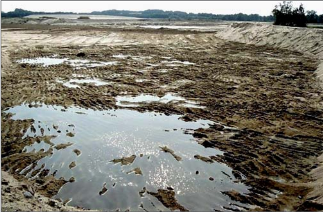
Foto 1: Spülfelder südlich und westlich des Flemhuder Sees/RD am 16.08.1986. Einrichtung des Spülfeldes: Die Außendämme sind frisch aufgeschüttet, die innere Unterteilung fehlt noch. Blick von Ost nach West.
